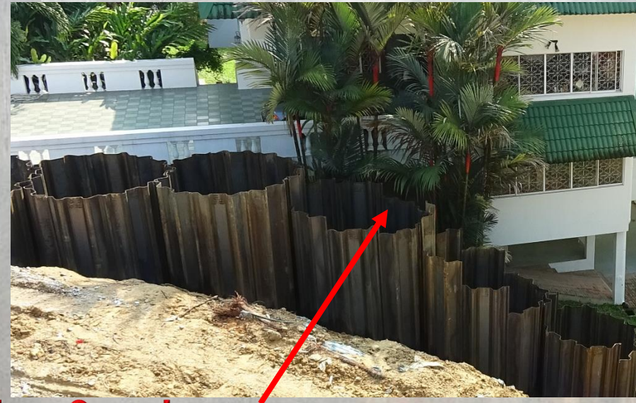
Caisson 3m piles 9m deep
