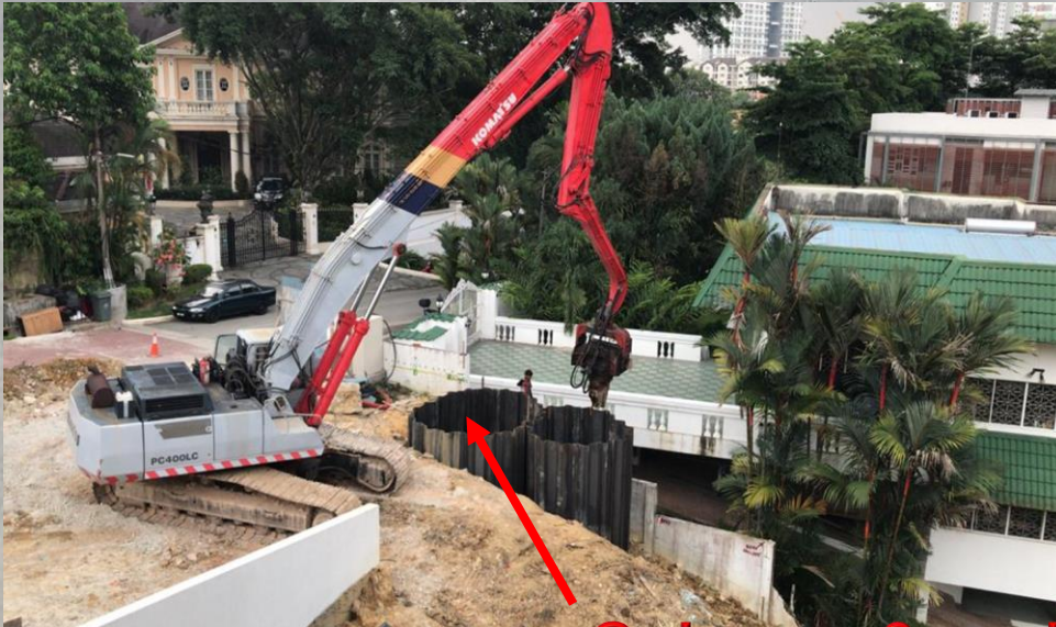
Caisson 3m piles 9m deep
